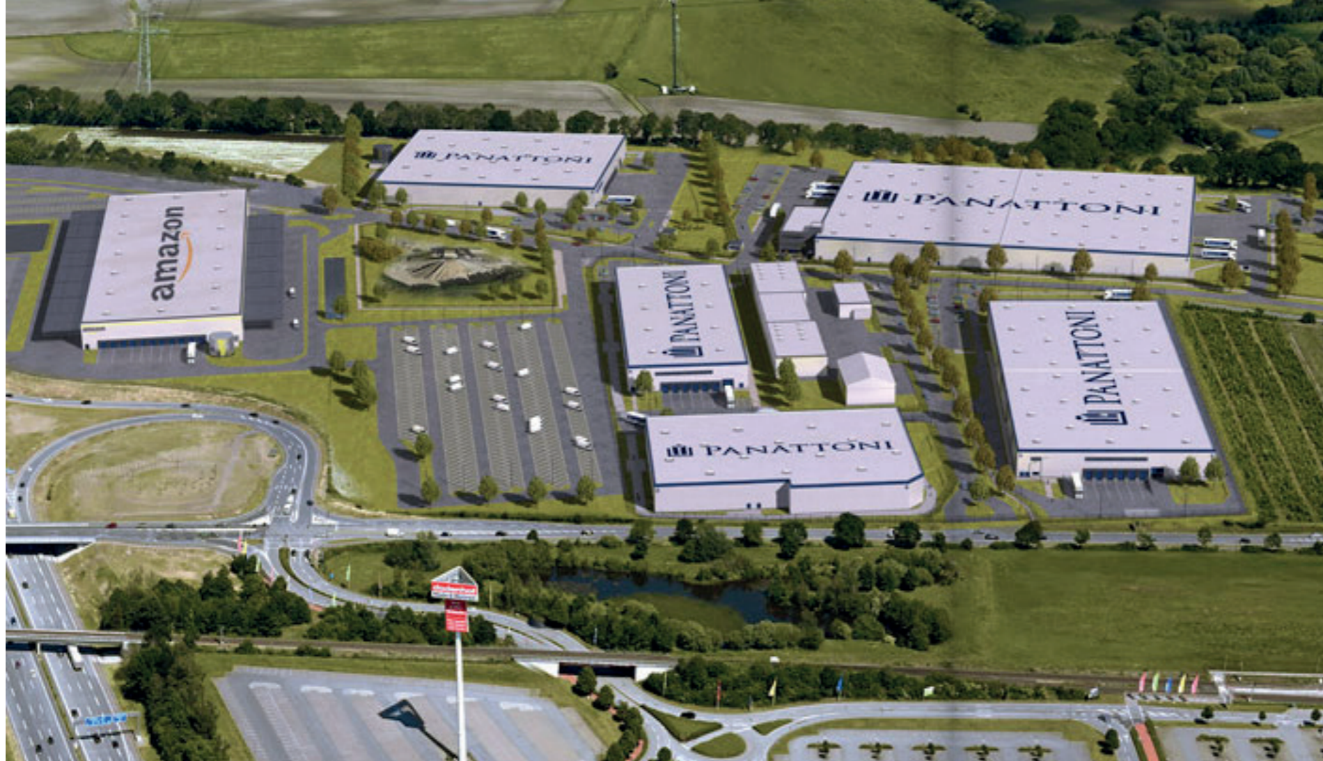
Im Norden Hamburgs entsteht ein Panattoni Park mit fünf neuen Hallen.
